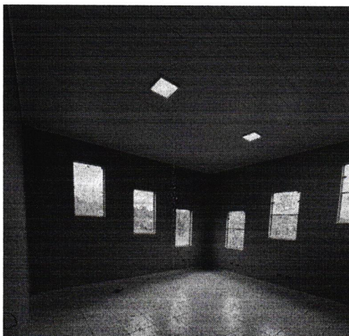
Figura 2- serviço de forro executado pela empresa que corresponde ao licitado.
