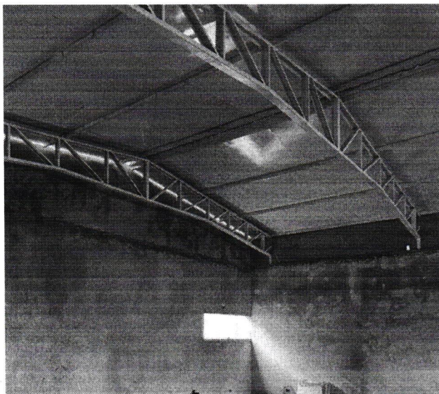
Figura 1- serviço de telhamento executado pela empresa que corresponde ao licitado.
